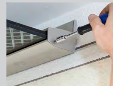
5 / Coller les embouts de finition et les visser.
