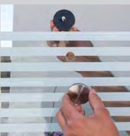
5 / Visser les fixations à œillet avec leur joint sur la dalle de verre côté mur vers le bas et sur l'avant vers le haut
