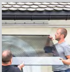
2 / Enfiler le profilé de protection des arêtes sur le verre (respecter le sens) et insérer ensuite la vitre dans le profilé de la marquise en plaçant les trous de perçage en bas.
